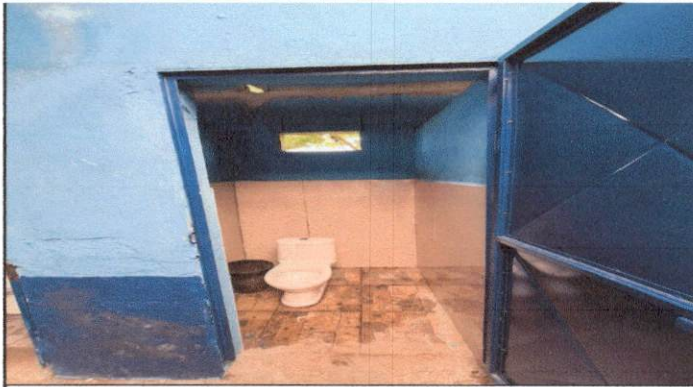
Foto 7: Sustitución e instalación de baños.
