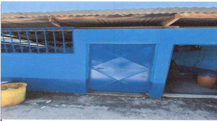
Foto 11: Sustitución e instalación de puertas.
