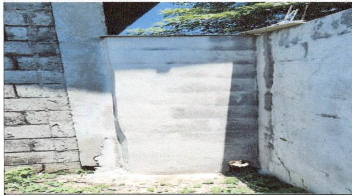
Foto 14: Reparación de muro perimetral de block.
