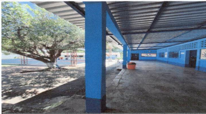
Foto 13: Reparación de columna debido al deterioro.
