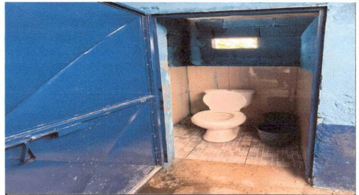
Foto 8: Sustitución e instalación de baños.
