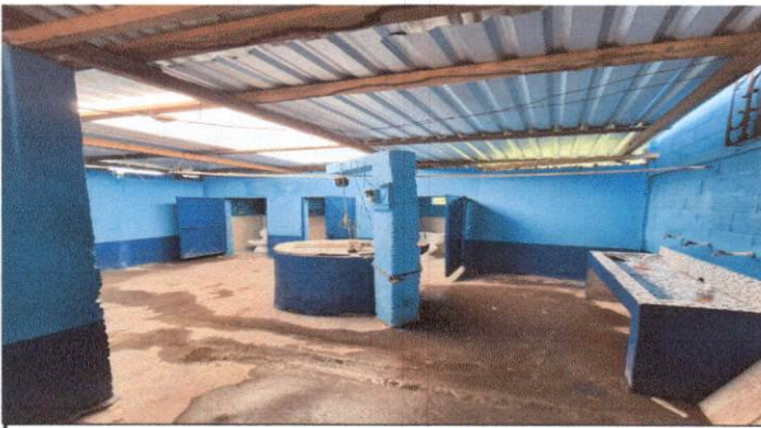
Foto 9: Cambio de lugar de pila y tubería para el agua de pozo.
