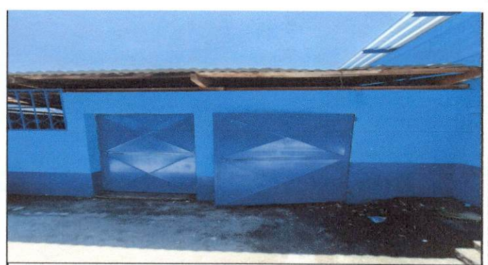
Foto 12: Sustitución e instalación de puertas.
